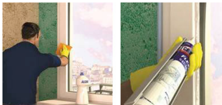
Figura 106 - Preparação e aplicação do selante
